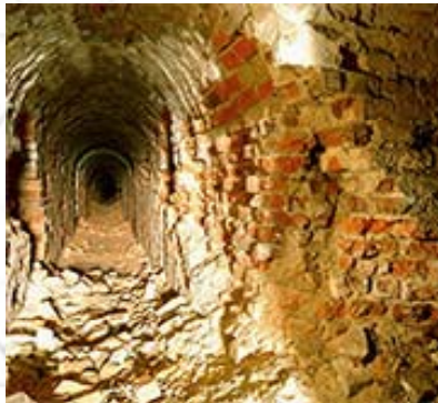
Graudenz: 2-Stöckiges Konterminensystem
